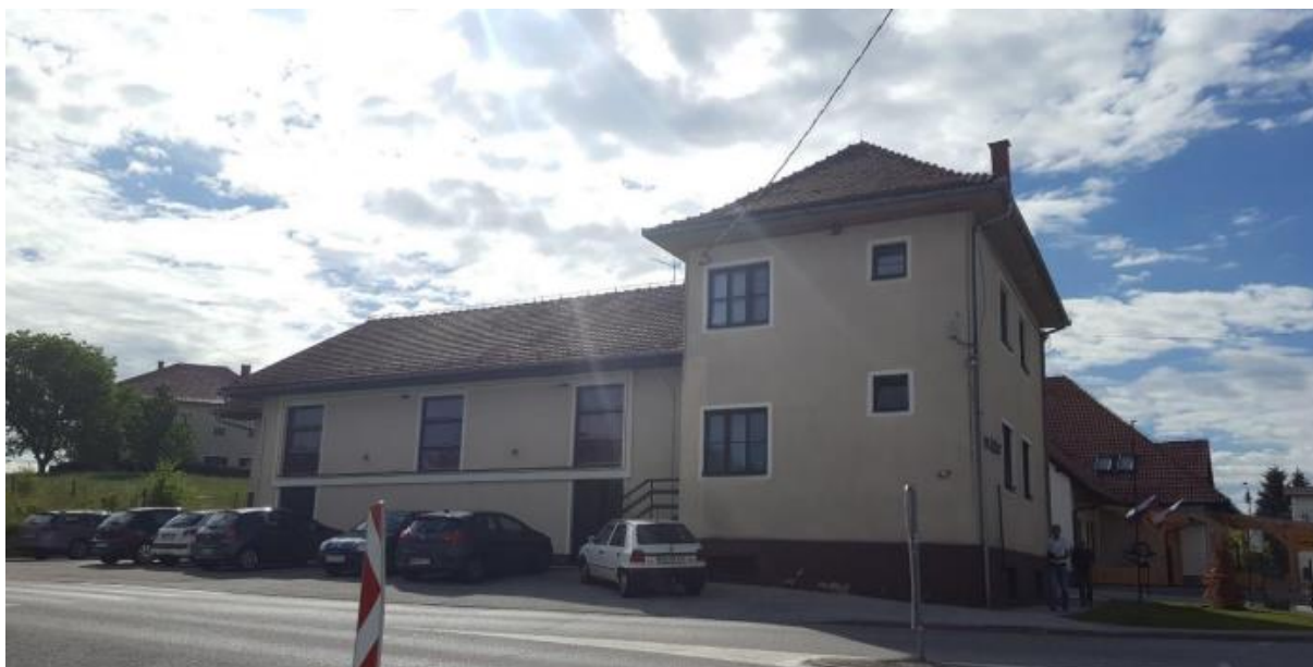
Slika 8: Prikaz objekta Dom kulture Črešnjevce
