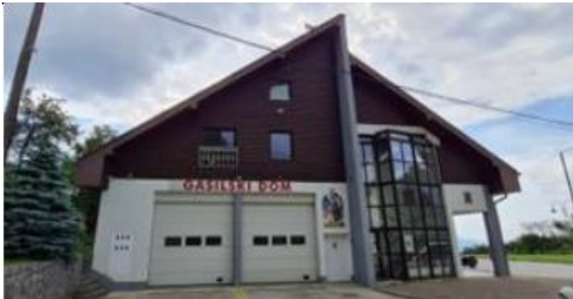
Slika 6: Prikaz objekta Večnamenski objekt Kebelj
