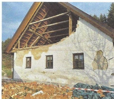
Slika 2: južna fasada-izpadel zatrepni zid
