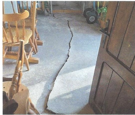
Slika 6: Razpokan in dvignjen tlak v kletni etaži
