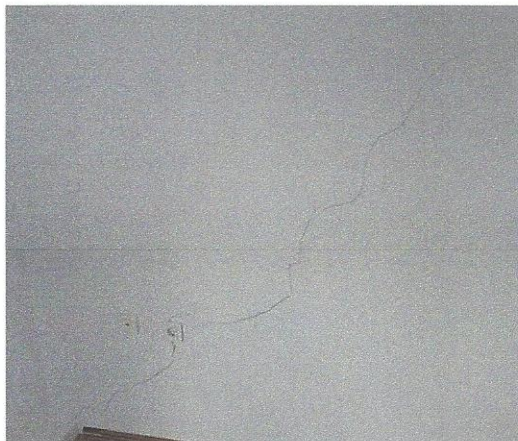
Slika 5: Diagonalna razpoka zidu v mansardi
