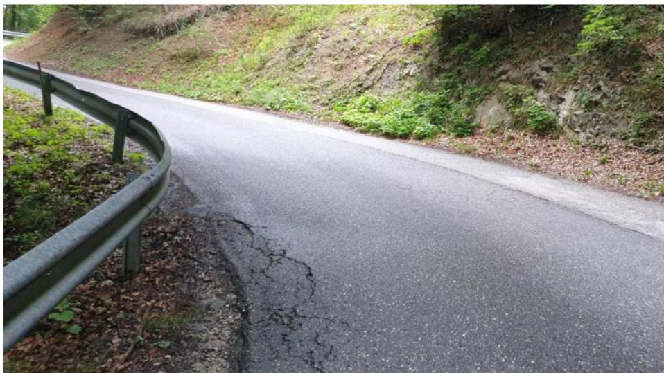
SLIKA 6: FOTOGALERIJA OBSTOJEČEGA STANJA VOZIŠČA
